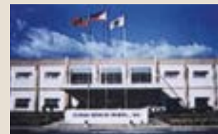
Hitachi Air Conditioning, Филиппины
